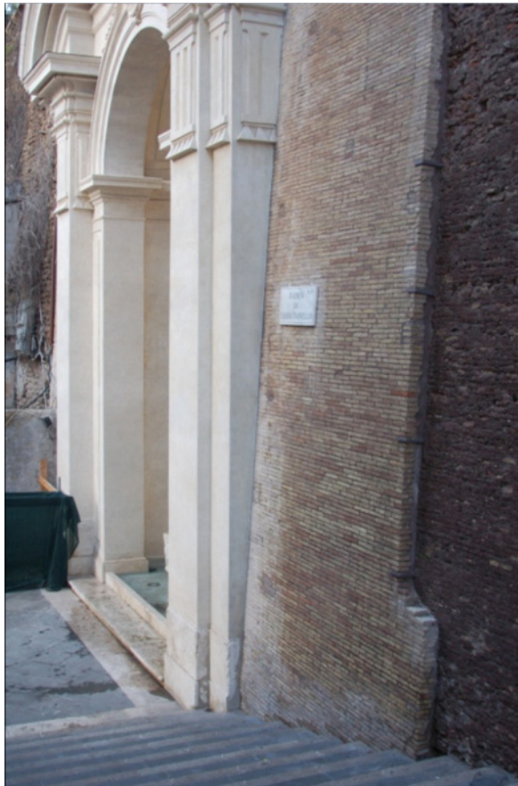
Abb. 2.58: Brunnen an der Rampa di San Sebastianello, ‚abgeschnittene‘ Ziegelsteinschale, ca. 1570 (Foto: H. Schlimme).
