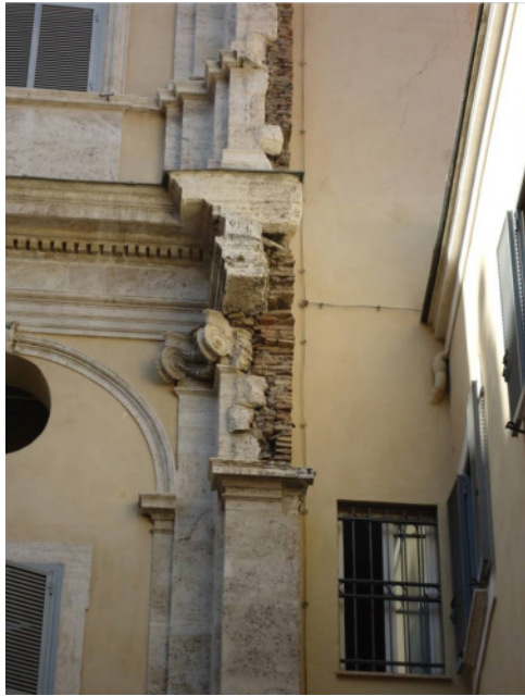
Abb. 2.63: Giacomo della Porta, Palazzo Maffei, 1577–1583, unvollendet, zweischaliges Mauerwerk (Foto: H. Schlimme).
