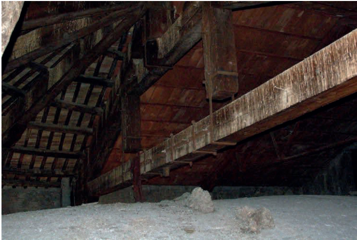
Abb. 2.90: Sant' Andrea della Valle, Rom, Dachbinder mit zwei Hängesäulen und gestoßenem Zugbalken, Anfang 17. Jh. (Foto: H. Schlimme, Genehmigung des Ministero degli Interni, Protocollo 0010636 vom 07/10/2009)
