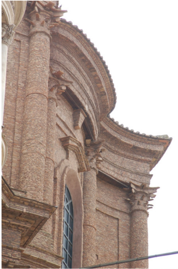
Abb. 2.59: Francesco Borromini, Sant'Andrea delle Fratte, Tambour, 1653–1663, tevolozza -Mauerwerk ohne Verputz (Foto: H. Schlimme).
