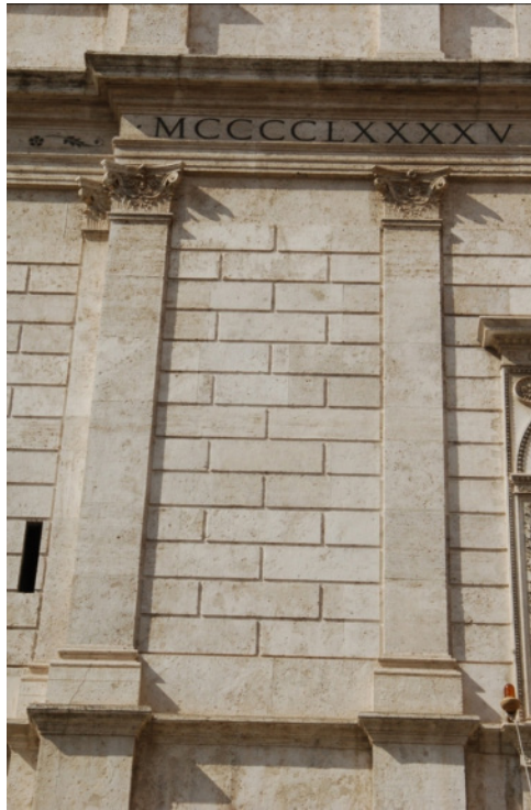
Abb. 2.66: Palazzo della Cancelleria, Rom, ab 1486, Fassadendetail (Foto: H. Schlimme).
