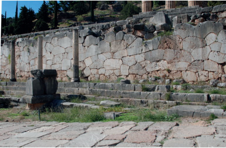
Abb. 2.19: Polygonale Stützmauer der Terrasse des Apollontempels in Delphi (E. Sioumpara).
